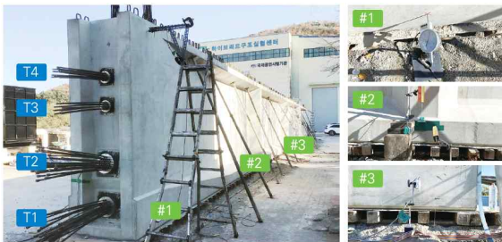
Fig. 3 횡변위 측정 변위계(LVDT) 설치
