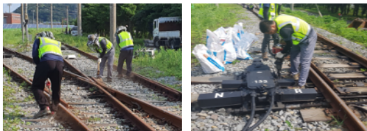
Fig.3 좌) 체결장치 및 가드레일 해체 우) 선로전환기 및 신호금구 해체
