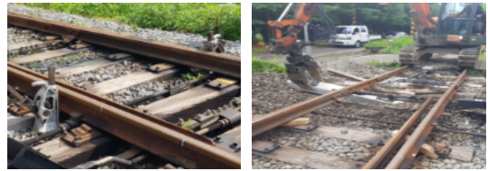
Fig.4 좌) 선로전환기 및 레일 들어올림 우) 콘크리트 침목 교체
