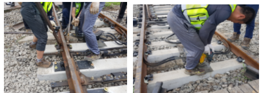
Fig.5 좌) 레일체결장치 체결 우) 신호금구 및 선로전환기 고정
