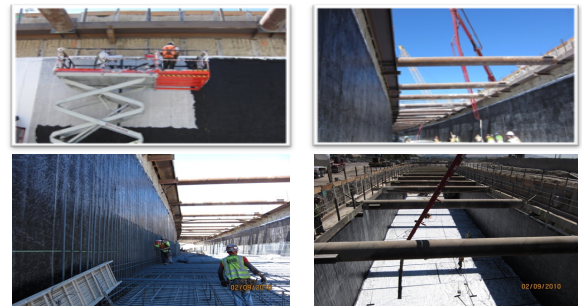
Fig.4 S.R.P.G 합벽 방수 공법 시공 현황
