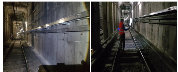
Fig.5 SRPG 주입공법 시공 완료 후(누수차단)
