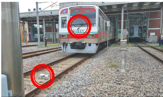
Fig. 6 지상송신기 및 차상수신기 설치위치
