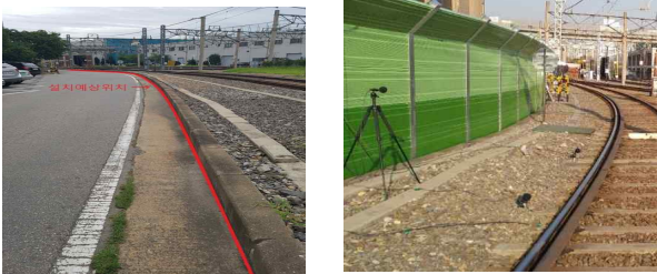
Fig. 3 방음벽(공명형 흡음판) 설치(전, 후) 출처:서울교통공사 보고서
