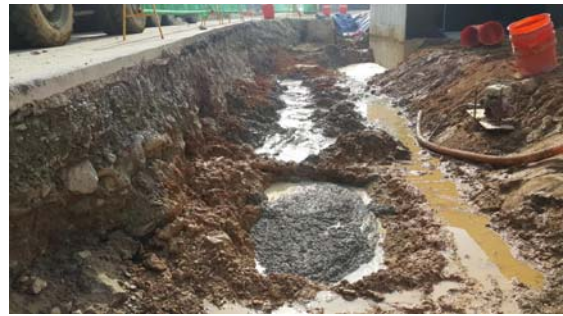
(a) Concrete Pouring
