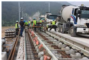
Fig. 4 Pouring concrete
