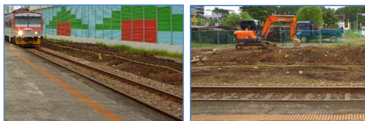
Fig. 3 철도 운행선 근접공사 시 경계표 설치 예
