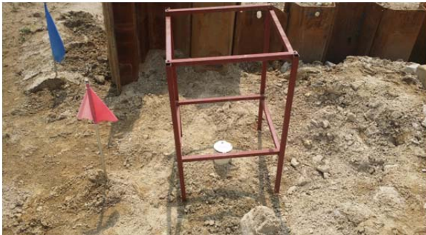
Fig. 5 지하수위계 설치
