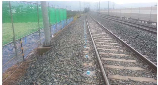
Fig. 6 선로 도상침하계 설치
