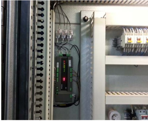
Fig 2. 52D2 특고압 배전반 멀티채널 계측기(18ch) 설치 사진
