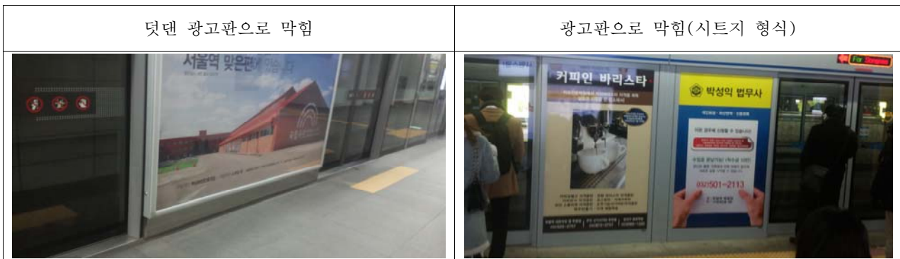
Fig. 1 차량출입문 외부비상개폐장치가 중앙PSD 광고판으로 막힌 사례
