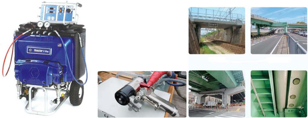
Fig. 2 폴리우레아 시공장비 및 교량에 적용된 시공사례 (일본)
