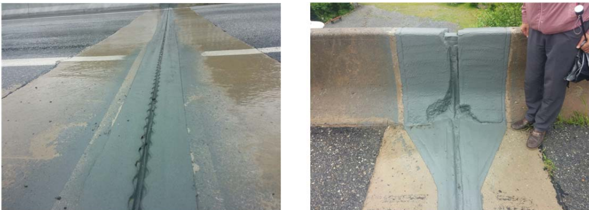
Fig. 1 중앙고속도로 봉명교 신축이음장치에 적용된 폴리우레아 방수공법 시공 사례 (시공 후 8개월 경과시점)
