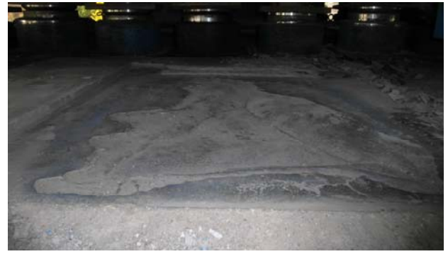
Fig. 1 받침 탈거 후 공극(공동)사진
