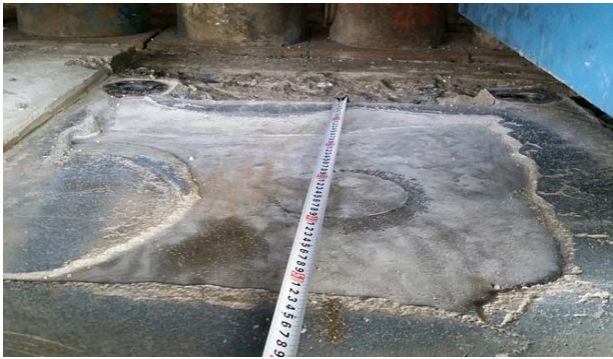
Fig. 1 받침 탈거 후 공극(공동)사진
