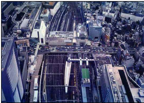
Fig. 2 공사 전 신주쿠역 모습
