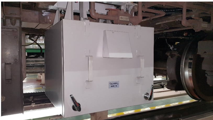
Fig. 5 차량에 모니터링장치를 설치하고 하우징커버를 덮고 설치를 완료한 모습
