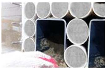
(d) Building Structures, Remove the Soil
