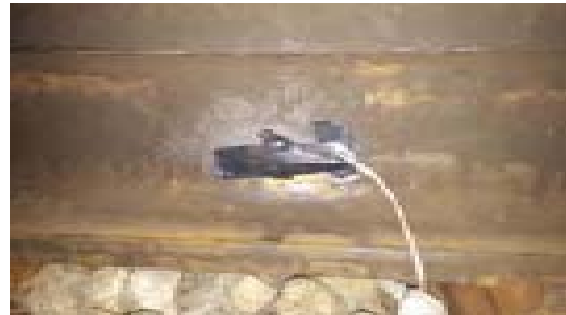
Fig 8 레일온도센서 설치
